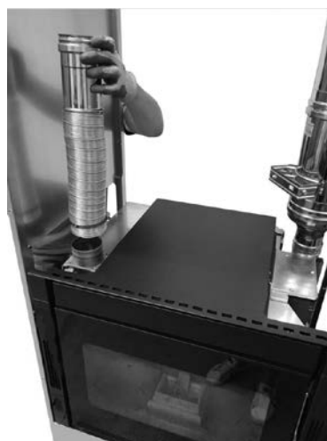
Fig. 68 - Introducción del insertable
