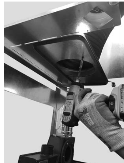
Fig. 73 - Fijar el tubo flexible
