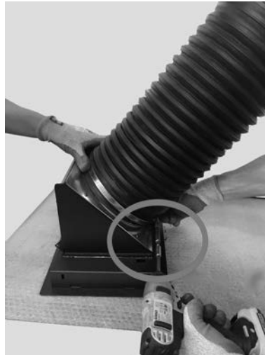
Fig. 70 - Apriete la abrazadera
