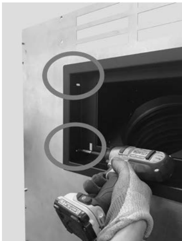
Fig. 74 - Fijación del exterior de la trampilla
